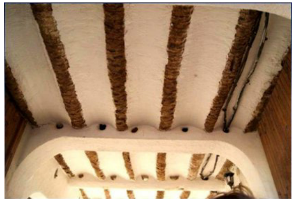
الشكل رقم (٢٠): سقف من جذوع النخل، المصدر: ديوان حماية وادي ميزاب، ٢٠١٥.
