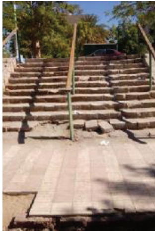
الشكل رقم (١٠): السلالم الواصلة بين الفراغات المختلفة في المناسيب ويتضح عدم ملاءمتها وتدهورها
