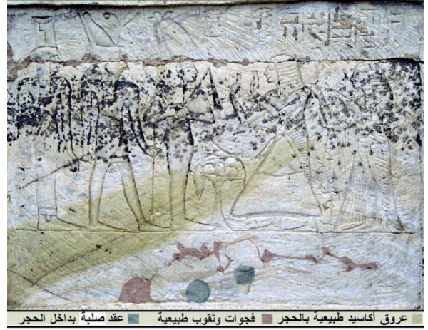
الشكل رقم (١٠). عقد صلبه وعروق وأكاسيد ملونة بالحجر الجيري بمقصورة ماعى.
