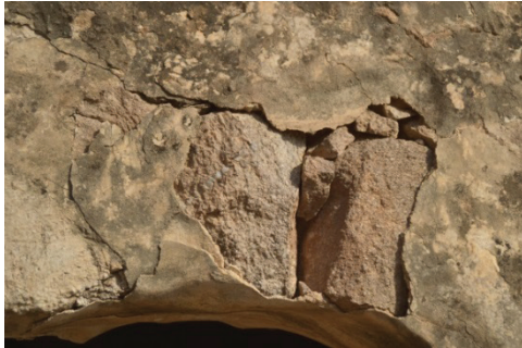
شكل رقم (٢٨) يوضح حدوث انفصال لطبقات الملاط عن سطح الحجر، "من تصوير الباحث".
