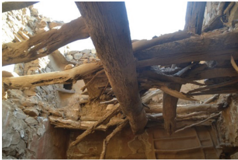
شكل رقم (٣٤) يوضح انهيار أجزاء من الأسقف الخشبية، "من تصوير الباحث".
