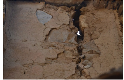
شكل رقم (٣١) يوضح حدوث شروخ نافذة في الجدار، بالإضافة إلى شروخ وتساقط في الملاط، "من تصوير الباحث".
