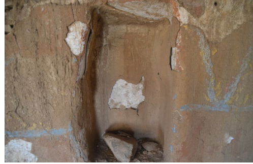
شكل رقم (٢٩) يوضح حدوث انفصال لطبقات الملاط عن سطح الحجر، "من تصوير الباحث".
