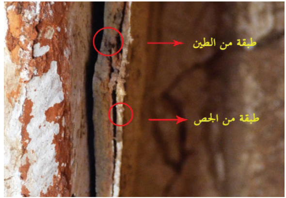
شكل رقم (١١) يوضح التركيب التشريحي لطبقات الملاط، "من تصوير الباحث".
