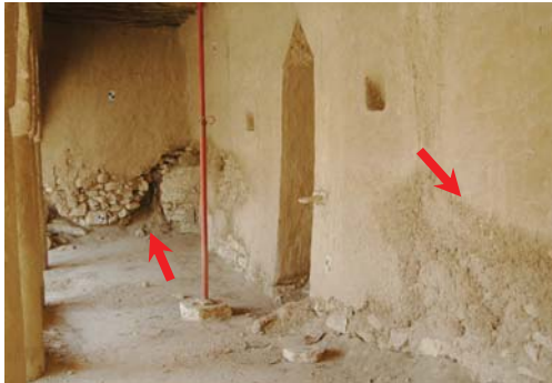
الصورة رقم (١١). جدار القبلة والمحراب المجوف ويظهر تلف الجزء السفلي من الجدران وتفكك بعض لبناتها.
