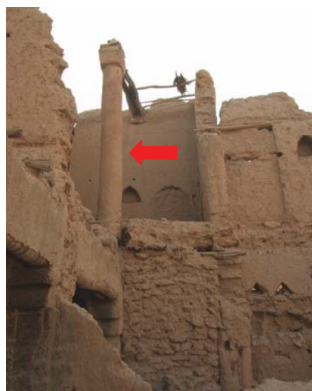
الصورة رقم (٢١). الركن الجنوبي الشرقي من السبالة، سقوط السقف جعل العمود حر من أعلى مما يجعله غير آمن إنشائياً وقابل لانتهيار لضعف تيبته من أسفل.
