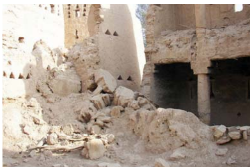
الصورة رقم (١) و (٢). طبيعة الطوب اللبن المستخدم في بناء مسجد وسبالة موزي.
