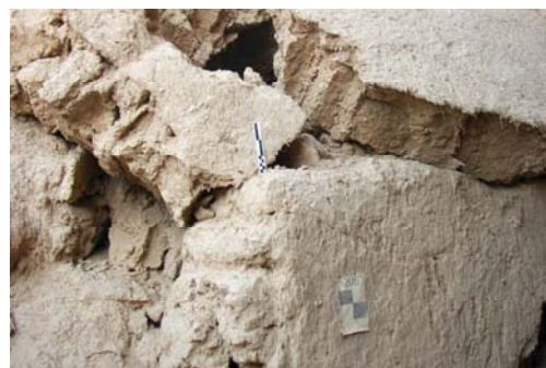
الصورة رقم (١) و (٢). طبيعة الطوب اللبن المستخدم في بناء مسجد وسبالة موزي.
