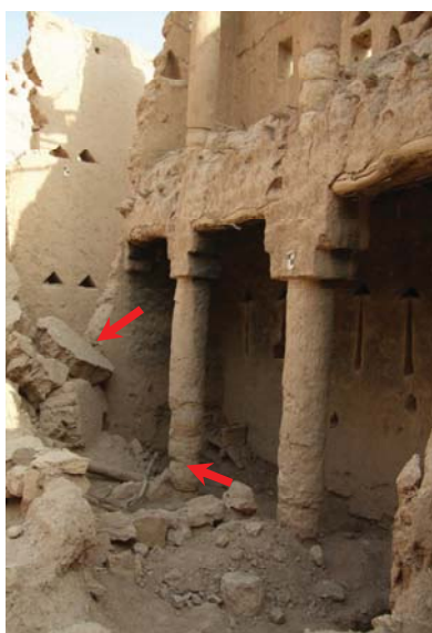
الصورة رقم (٢٢). تهدم الجدار الخارجي ناحية الشمال للسبالة وتآكل السطح الخارجي لخرز العمود السفلي.
