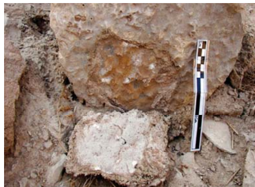
الصورة رقم (٣٨). انفصال طبقات المونة عن خرز الأعمدة نتيجة تبلور الأملاح.
