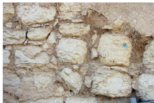
الصورة رقم (٣-أ، ب). استخدام مادة الحجر الجيري في بناء الأساسات والمداميك السفلى بمبنى مسجد وسبالة موزي.
