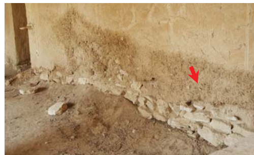
الصورة رقم (١٢). صورة مقربة للجزء من جدار القبلة توضح تآكل طبقة الملاط وتفكك مداмик الأحجار السفلية بالجدار.
