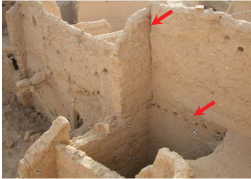
الصورة رقم (٢٦). السقف الخشبي للغرف بالمنطقة الغربية من السبالة، وتشرخ وانفصال بالجدران اللبن.
