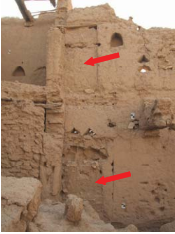
الصورة رقم (٢٤). سد بابين في الجانب الجنوبي من السبالة، للجدار المشترك بينها وبين المسجد، عند مستوى الخلوة، ومستوى المسجد (أعلى سقف الخلوة).
