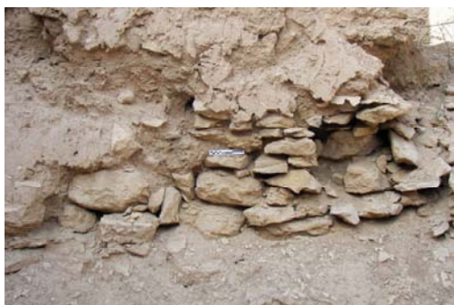
الصورة رقم (٣-أ، ب). استخدام مادة الحجر الجيري في بناء الأساسات والمداميك السفلى بمبنى مسجد وسبالة موزي.
