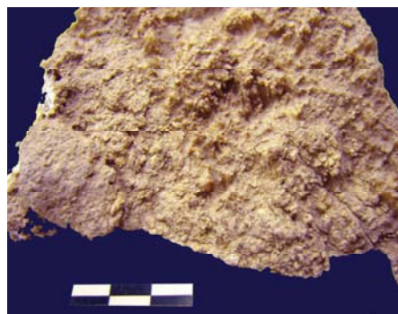
الصورة رقم (٤١-أ، ب). التكلسات الملحية وانفصال الطبقات السطحية بأحجار مسجد وسبالة موزي.
