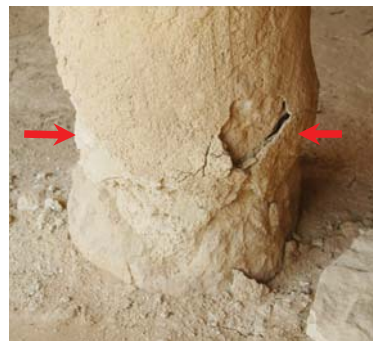
الصورة رقم (١٤). صورة مقربة للجزء السفلي من أحد أعمدة المسجد توضح تآكل الملاط الطيني بخرز العمود السفلي.
