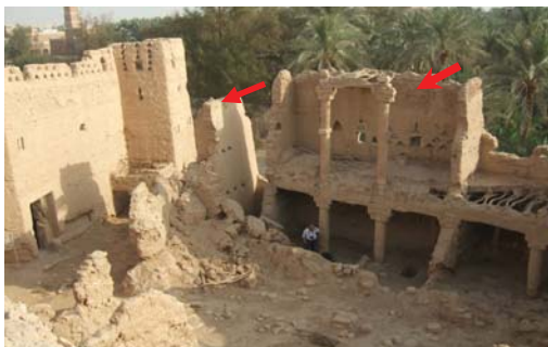
الصورة رقم (٢٠). تهدم جدران الطابق الأول بالجانب الشرقي والشمالي من السبالة وتساقط سقف الطابق الأول مع ميل خطير في بقية الجدار الشمالي للسبالة.
