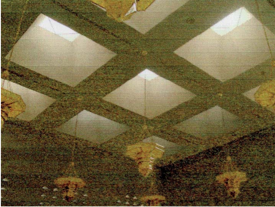
سقف مسجد الملك فهد
