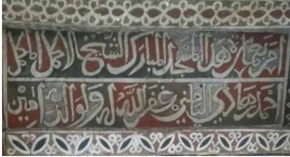
الشكل رقم (٣). نقش كتابي بسقف المسجد يوضح اسم المنشئ. الباحث
