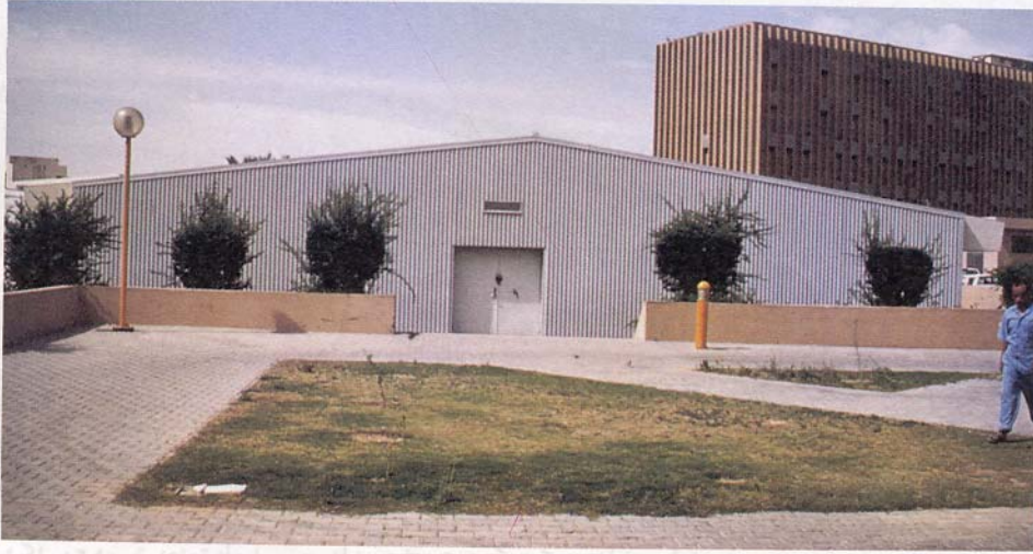
شكل (١٨). شملت المباني الجاهزة المستودعات اللازمة لتخزين كافة مستلزمات المرضى. توضح الصورة أحد المستودعات التي أنشئت حديثاً.
