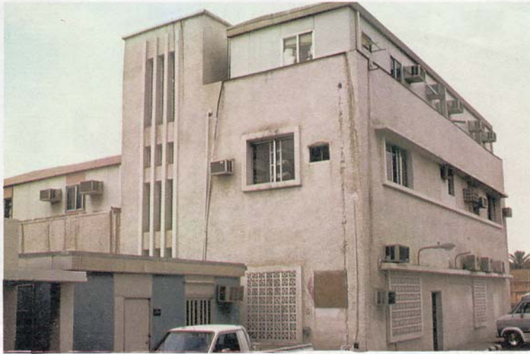
شكل (٢١). شملت التغييرات على وظائف المباني بناء ملاحق علوية من المباني الجاهزة والخفيفة والتي تمثلها التغييرات على أحد المباني الخاصة بسكن الأطباء ومساعدتهم بالمستشفى.
