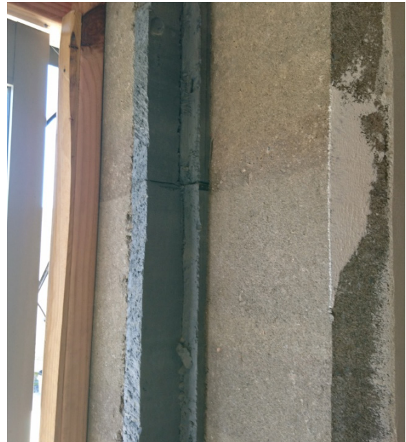
الشكل رقم (١٤). توضيح الصورة حائطين ترابين بينهما مادة عازلة، في نيوزيلاندا، ويستخدم العزل في الحوائط الترابية في المواقع الباردة.
