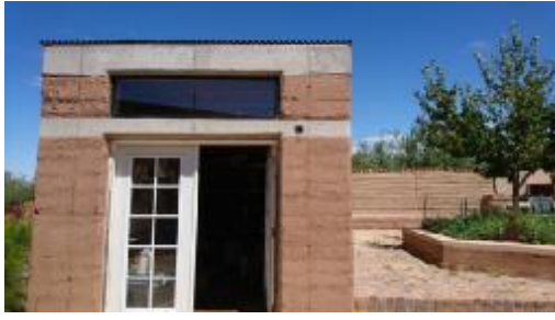
الشكل رقم (١٠). بيت كوينتن برانش في أريزونا الذي زاره الباحث في صيف عام ٢٠١٦، وقد تم بناء البيت بالتربة المدكوكة المثبتة بالأسمت وإلى اليسار يظهر ملحق البيت ويتضح الجسر الخرساني بلونه الأسمتي.
