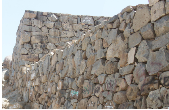
الصورة (٤): جزء من الحوائط الصخرية الساندة بدكة بافيل (عدسة الباحث).
