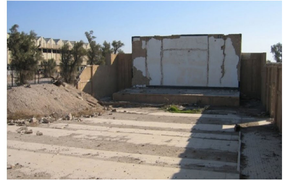
الشكل رقم (٤) الأبنية الأولى المهتمة تظهر في بقاياها بوضوح تقنيات ومواد البناء التقليدية (الطابوق واللبن) والتي استخدمت بشكل واسع في أبنية مطار الشعبية (الباحث)
