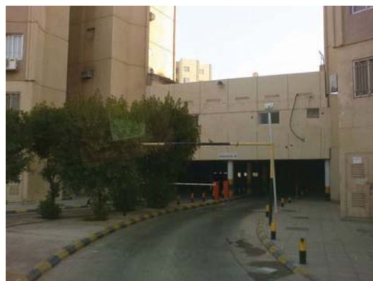
الشكل رقم (٢٣). البوابات الآلية لأحد مواقف المشروع.
