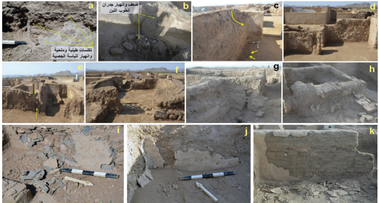
شكل رقم (٣): a, b: يوضحان تبلور الأملاح واختيار جزئي في الجدار الطيني، c - h: توضح ضياع معالم الجدران الطينية بسبب عوامل التعرية بمنطقة قرح، i, j, k: توضح سقوط واختيار طبقات الملاط في موقع قرح الأثري
