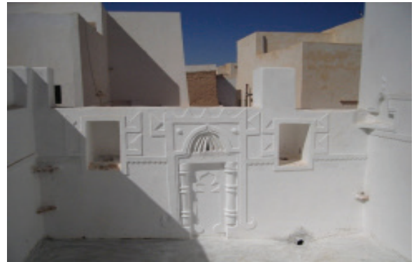
صورة ٢٤: الجدار بعد تكسيته بالنورة (شَبَّام حضرموت) [عن: عيد، ٢٠١١م].
