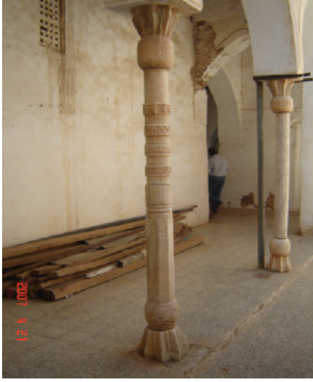
صورة ٢٨: عمود دائري من كتل حجرية مزخرفة في جامع المنصورية في جبن (تصوير الباحث) واستمر استخدام الأعمدة في البناء التقليدي في اليمن؛ فنجدها- الآن- في كثير من المناطق مثل: مدينة صنعاء، ومدينة تعز، ومدينة إب، ومدن وادي حضرموت (الصورتان ٣١، ٣٢).
