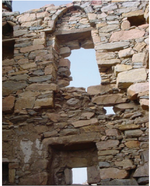
صورة ١٣: جدار مبنى يظهر بناء الجدران المزدوجة؛ وقد أزيل جزء من الجدار الداخلي (تصوير الباحث)
