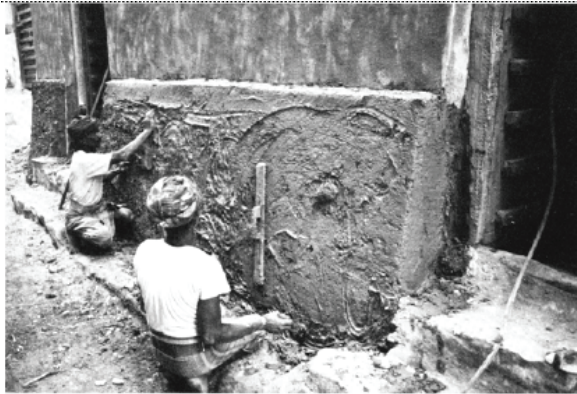
صورة ٢٢: التكسية بالطين للدور الأرضي (شَبام حضرموت).
