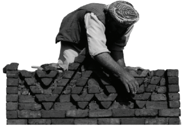
صورة ٨: سهولة التشكيل باستخدام تقنية البناء بالطوب المحروق اليَاجُور [طاهر، ٢٠٠٥م، ٤٦٤].
