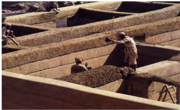
صورة ٥: توضح بناء جدران الزَّابُور [الغزالي، ٢٠٠٥م، شكل ١-٢٧].
