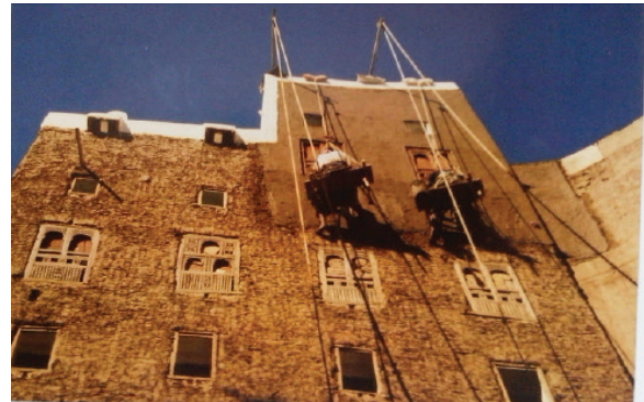
صورة ص ٢١: التكسية بالطين للأدوار العليا (شَبام حضرموت)
