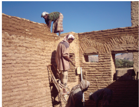
صورة ٣: بناء مبنى حديث بتقنية البناء باللَّبْن في وادي حضرموت (تصوير الباحث).
