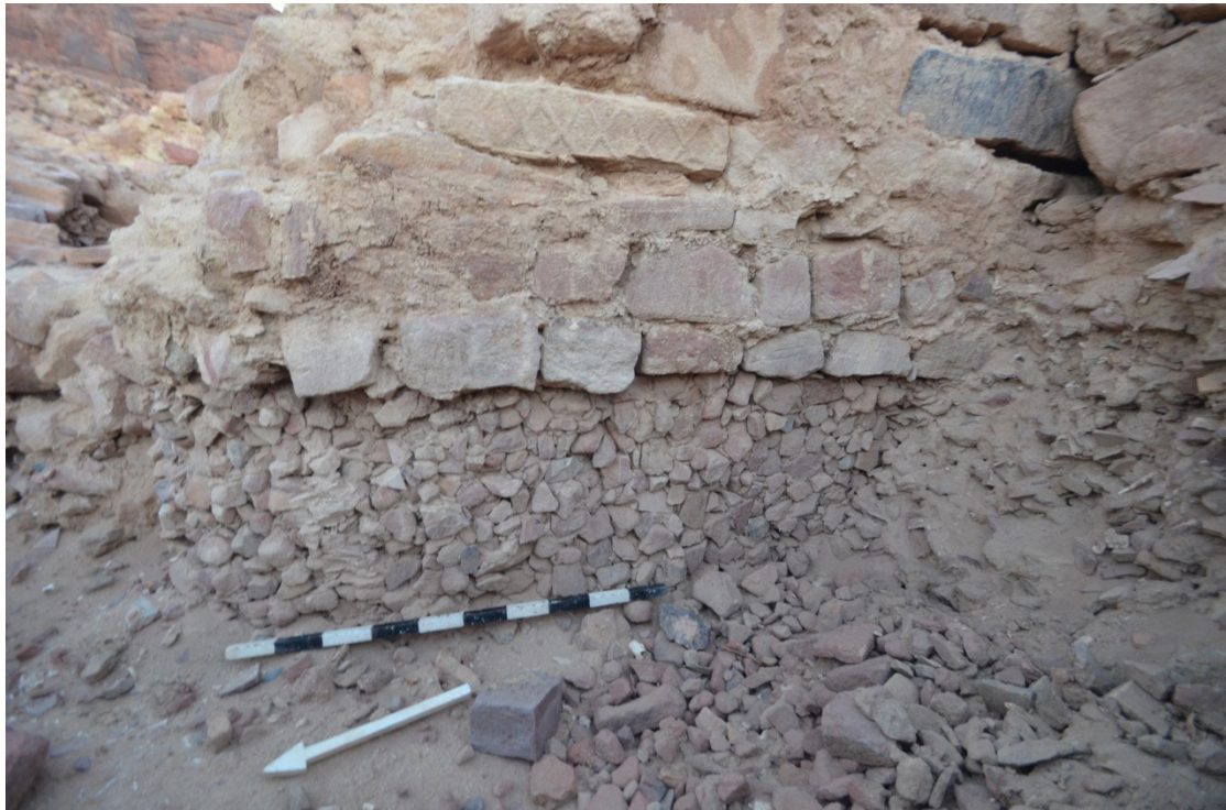
لوحة ٤ب: الدبش ورديم الأحجار المستخدم في أساسات البناء. (Alsuhaibani, 2015, pl. 102.B)
