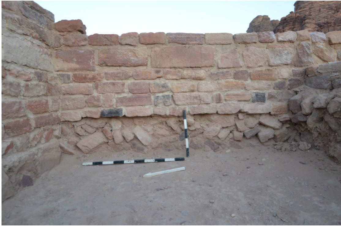
لوحة ٤أ: تقنية البناء بالأساسات المائلة (Alsuhaibani, 2015, pl. 101.A)
