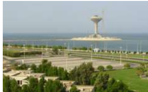
الشكل رقم (٣٩). خزان المياه.
