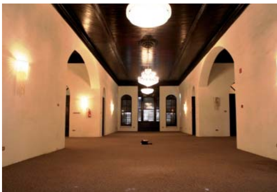
لوحة رقم (٢٠). قصر علي باشا بن عون: الطابق الثالث، الدورقاعة الوسطى والأواوين الأربعة المتعامدة عليها.
