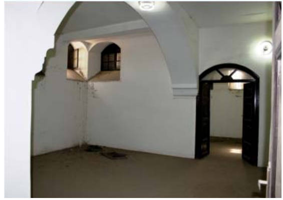
لوحة رقم (١٠). القبو: منظر عام للقاعة الجنوبية ويلاحظ العقد الذي يقسمها وفتحات النوافذ.
