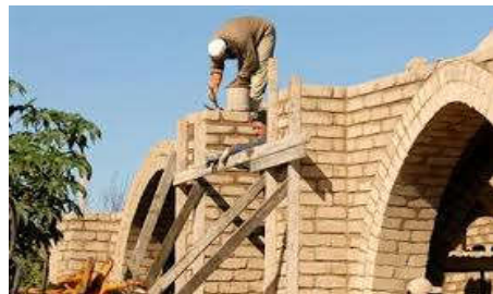
الشكل رقم ١٢: بناء البيوت الجديدة - المصدر وزارة الإسكان
