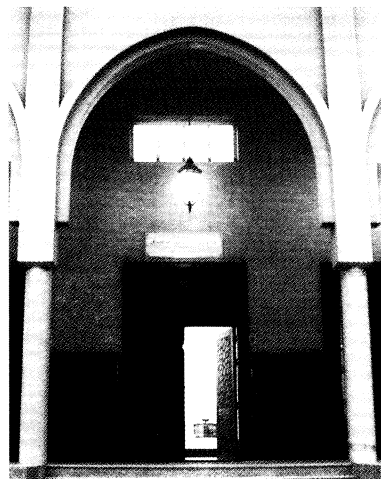
الشكل رقم (٩٨). قوس مدبب.
