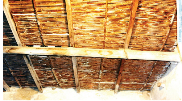
صورة رقم ١٢: مكونات السقف من الداخل، العارضات الخشبية وأعواد القصب
