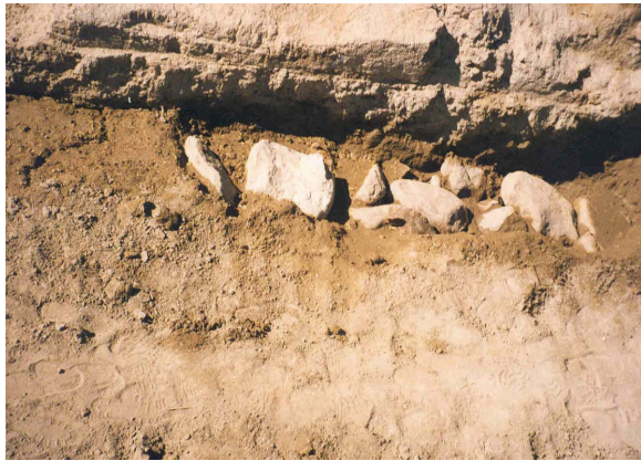
صورة رقم ٨: أساسات بناء الجدار
