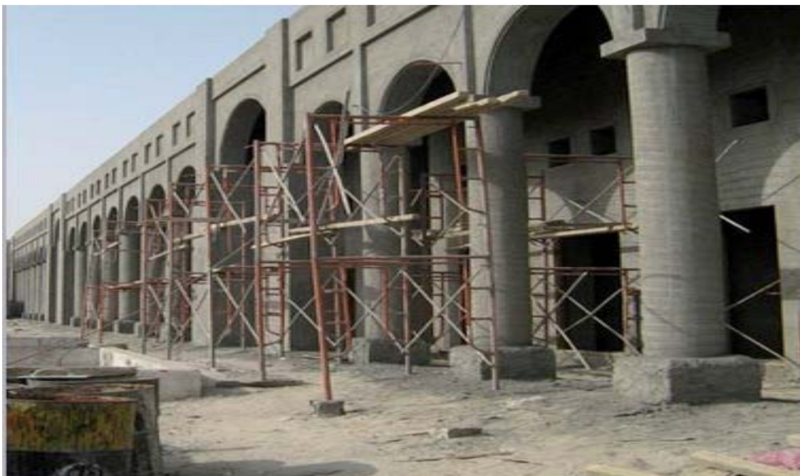
الصورة رقم (٢٧). مشهد حديث للعملية النهائية لإعادة بناء سوق القيصرية التاريخي.
